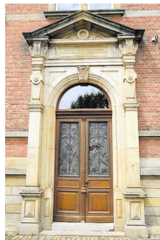
Das historische Eingangsportal des ehemaligen kurfürstlichen akademischen Gymnasiums am Kollegienplatz. Hier könnten bald Studierende ein- und ausgehen.
