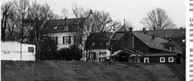
„Die Erft hat hier binnen 20 Stunden eine Erosion vollbracht, für die die Natur normalerweise Jahrausende gebraucht hätte“, sagt Dipl.-Ingenieur Ulrich Muris.
